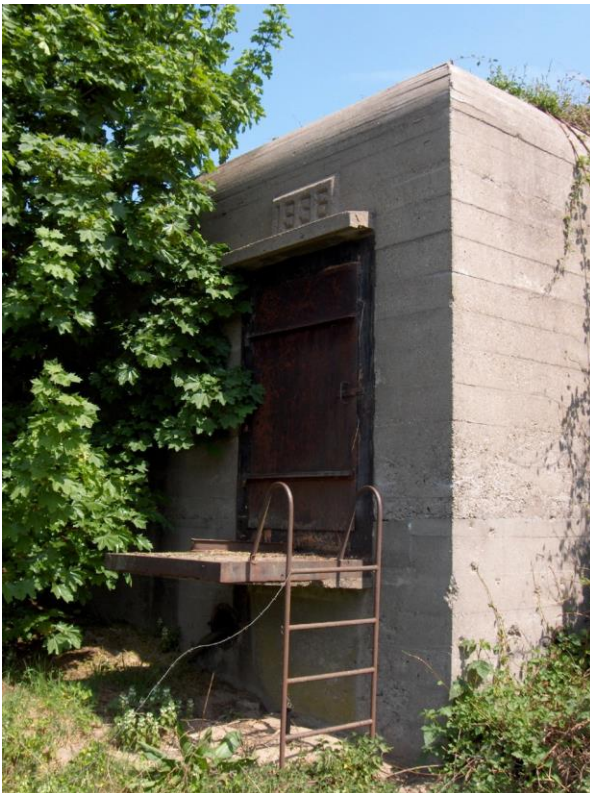
De ingang van de kazemat aan de zijde van een pad naar het achtergelegen boeren erf.
