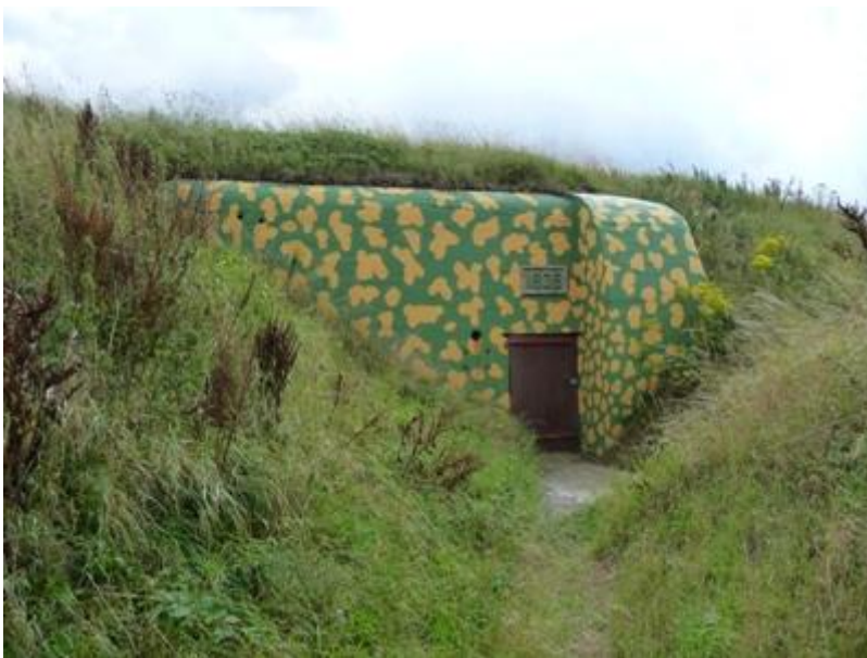
Ingang met rechts de uitstekende betonnen muur van de kanonkazemat Diefdijk-Zuid
