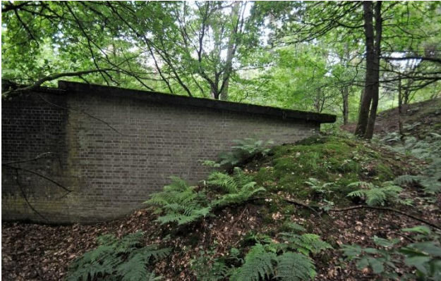
Zijaanzicht van de kop van de baan met daarin de kogelvanger. Erboven is een betonplaat aangebracht. Rechts op de foto is de kogelvanger uit de Tweede Wereldoorlog te zien.
